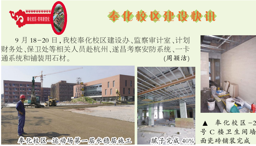
▲ 奉化校区-2号C楼卫生间墙 面瓷砖铺装完成
